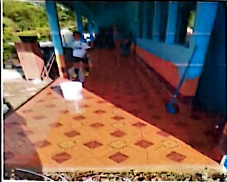
Foto 1: piso ceramico instalado en las tres aulas y corredor
