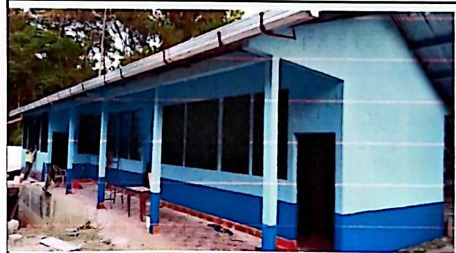
Foto 4: pintura en exterior e interior
